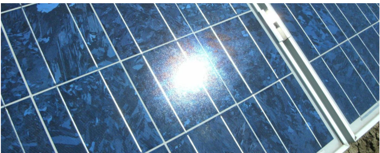
Bild 3.2.2: Diffuse Reflexion von direkten Sonnenlicht (Einstrahlung ca. 980 W/m 2 ) auf einem PV-Modul (Quelle: SolPEG)
